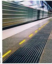
Mögliche Art der Anzeige freier Zugteile: LED-Leitsystem von SIUT mit Farbsignalen
