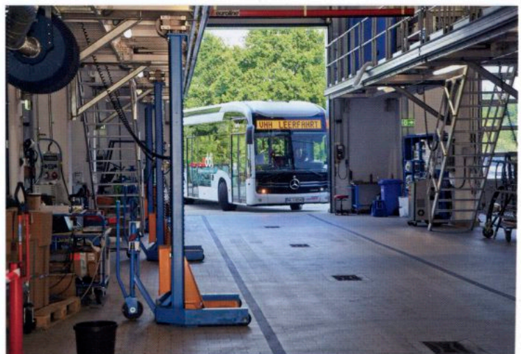
Bild 1: Eine optimale Werkstattplanung berücksichtigt die Erfordernisse des Betriebs (Bild: INIT/Ulrike Kabel)
